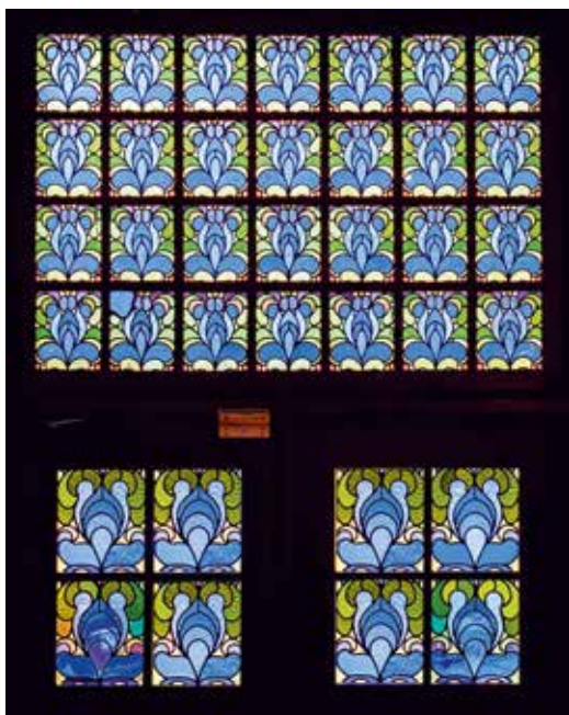
Nr kat. 76 Ul. J. Piłsudskiego 36 Witraże częściowo zniszczone Fot. M. Walaszczyk Fot. a. uzupełniono brakujące fragmenty
